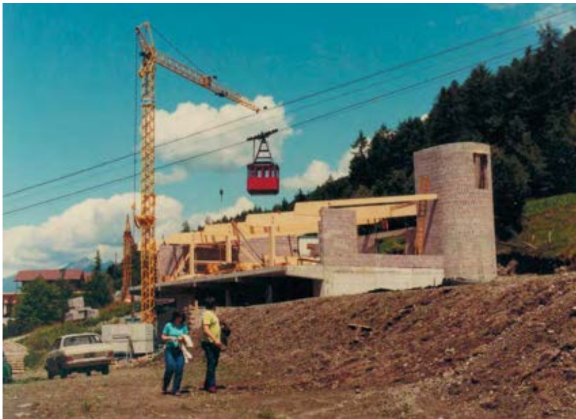
Abbildung 47: Der Bau der Feuerwehrrhalle 1979 — 1981
