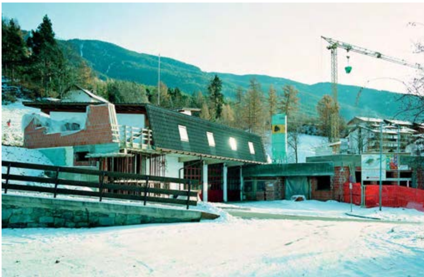
Abbildung 96: Der Bau der Feuerwehrhalle — 1992—1994
