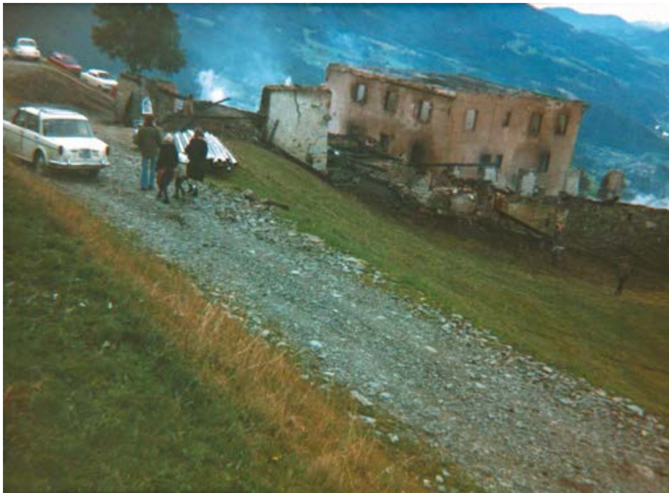
Abbildung 28: Der Gasserhof — St. Leonhard nach dem Brand — 1975
